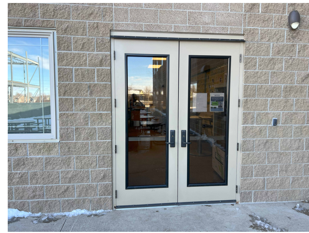
HS Commons south door - Demolition
