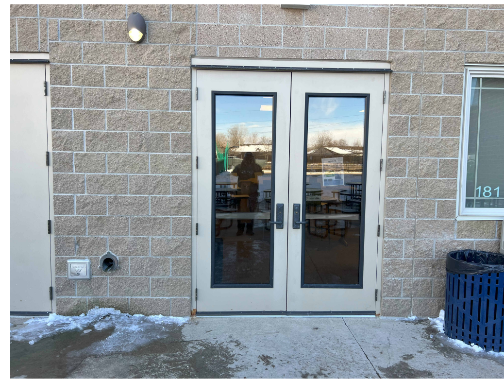
HS Commons north door - Demolition
